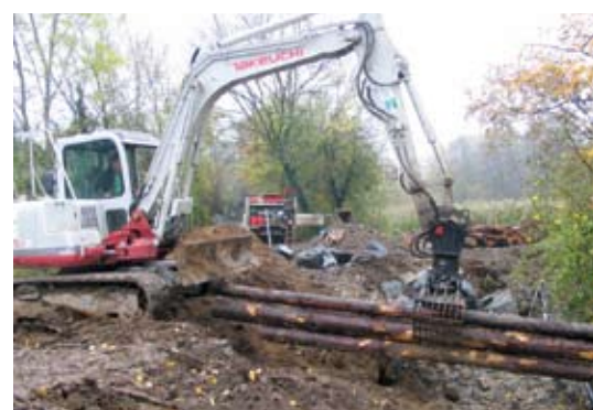
5 seuils en mélèze ont été posés sur le Fondagny.
